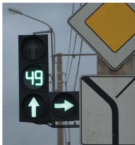
Рис. 3. Светофор со светодиодной стрелкой в центральной секции
