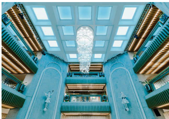
В крыше атриума имеются 9 мансардных окон и 12 фальш-окон с функцией искусственного освещения
